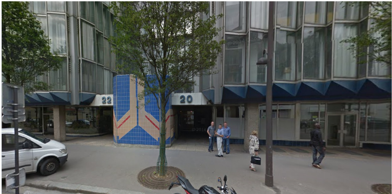
Rue du Château des Rentiers, Paris
